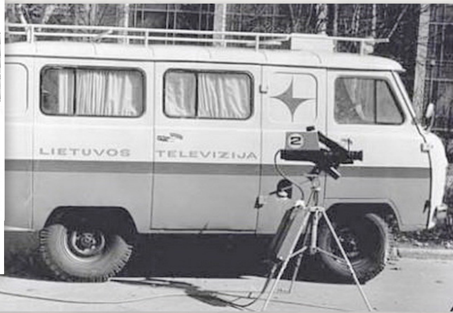
Передвижная репортажная станция на базе автомобиля УАЗ-452А
