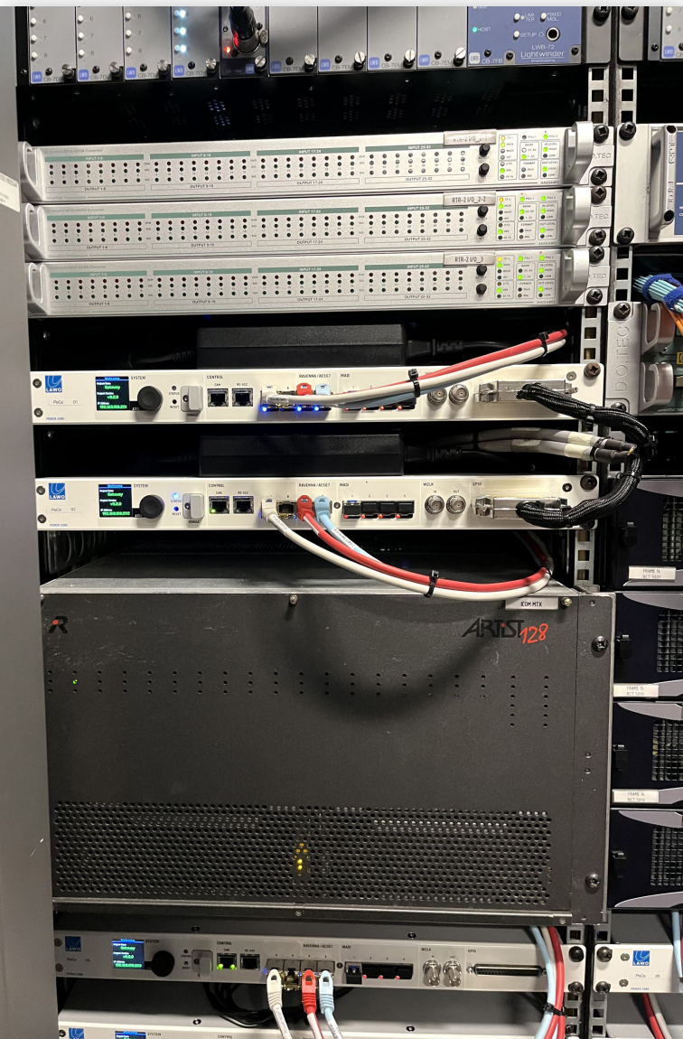
Шлюзы Power Core, отвечающие за сопряжение сигнальных трактов и IP-сетей
