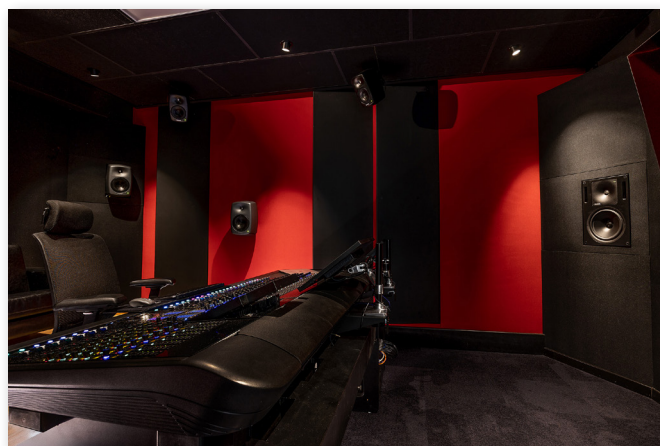
Комплексы Titrafilm в Париже оснащены средствами объемного мониторинга и полностью сетевой аудиоинфраструктурой
