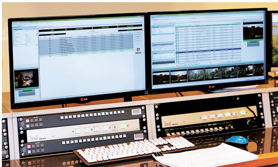
Система AutoPlay, установленная в резервном автоматизированном эфирном комплексе ВГТРК
