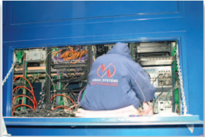
Идет монтаж кабелей и коммутационных панелей
