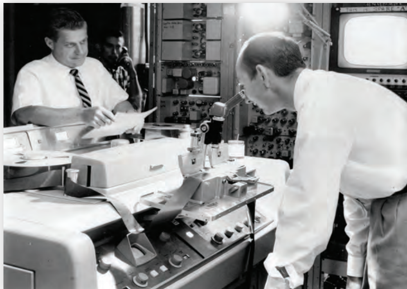
Рис. 8. NBC Video Tape Center (Нью-Йорк): идет процесс монтажа с помощью BM Ampex Quadriplex
